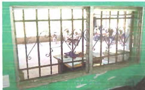
Foto 2: Sustitución de ventanas; sistema de apertura: Corredizas, Perfiles color blanco estándar, Material del marco: PVC Material de la ventana: Vidrio, sellado perimetral.
