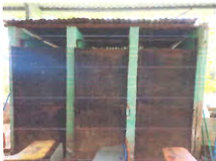
Foto 1: Suministro e instalación de puertas metálicas en el área de sanitarios, incluyendo pasadores y bisagras.
