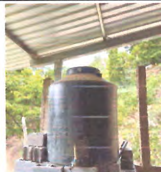
Foto 4: Reparación de cisterna, accesorios de tanque de almacenamiento de agua y base metálica.
