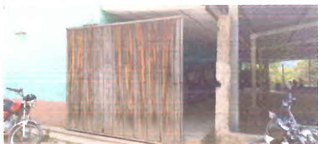
Foto 5: Sustitución de portón de ingreso, material: metálico, incluye: bisagras y sistemas de cierre.
